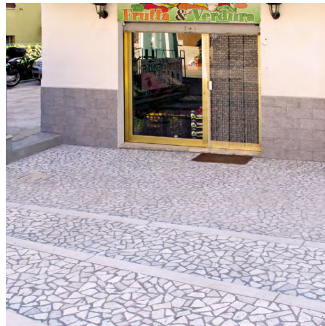
PALLADIANA BURATTATA DI TRAVERTINO
